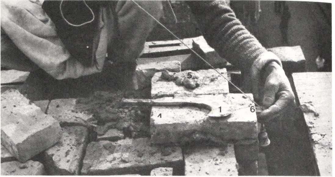
344 The brick layer (dākaḥmi) using the plumb bob (khāgā).
